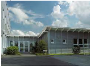
■ KABELSCHLEPP Service-Center Hünsborn
